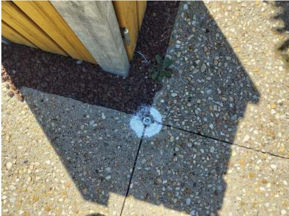
Une photo en gros plan du repère topographique. Il s'agit d'un clou en acier fixé dans un trou percé dans un trottoir en béton. Le clou est entouré d'un matériau de remplissage grisâtre. |
